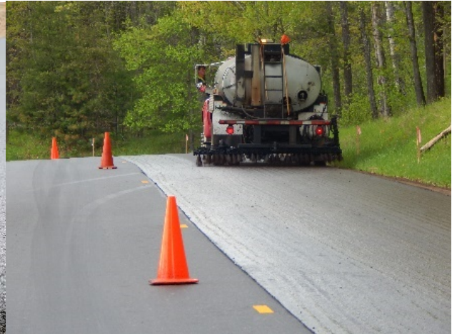
(d) Leveling emulsified asphalt application
