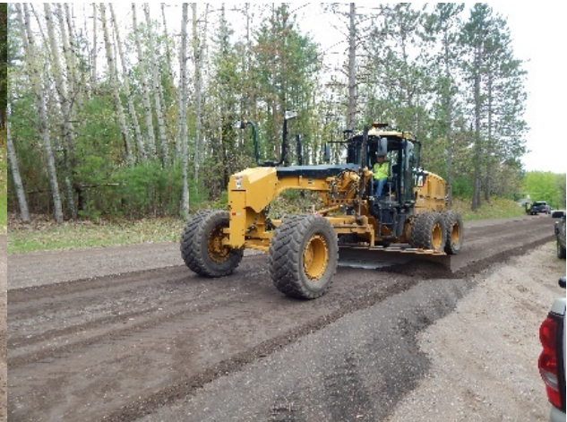
(d) Leveling after compaction
